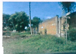
VOLTEO DE MURO POR FALLA DE CIMENTACIÓN VISTA EXTERIOR
