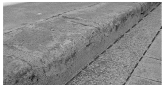
Señalamiento de franja vehicular sobre arroyo vehicular.
