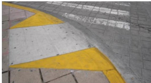
Rampa ubicada en Calle Degollado esq. 16 de Septiembre
