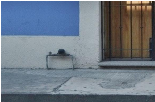
Registros hidráulicos y eléctricos en área de fachada.
